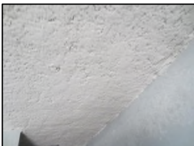
Photo N° 610 ECH-N°1 FLOCAGE -- HALL Plafonds BLANC COTONNEUX
